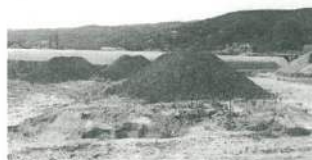
La dépollution du site des Ets Gaillard
